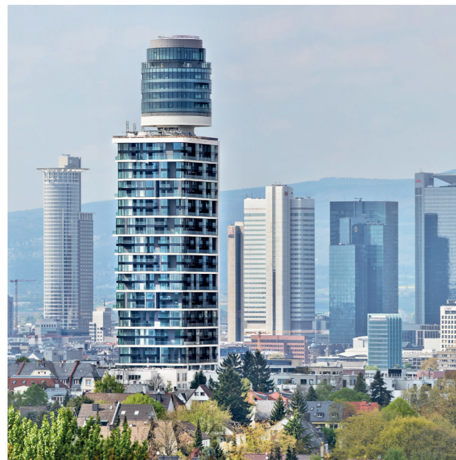
Henninger-Turm und Stadtgärten, FST-Kombiboxen Beton
