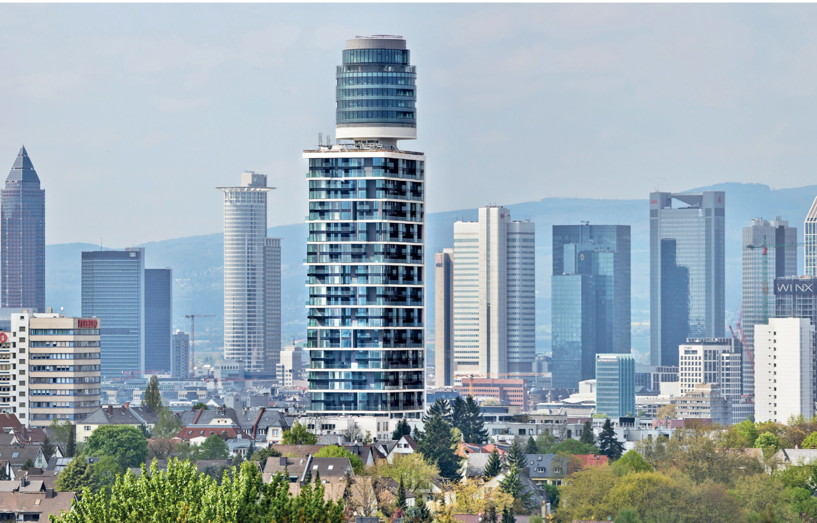
Henninger-Turm und Stadtgärten, FST-Kombiboxen Beton
