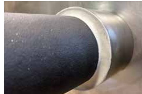
Konventionelle Ausführung für A-60 (Metallhülse)
