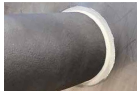
Nicht-konventionelle Ausführung für A-60 (ohne Metallhülse)
